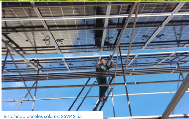
Instalando paneles solares. SSVP Siria
